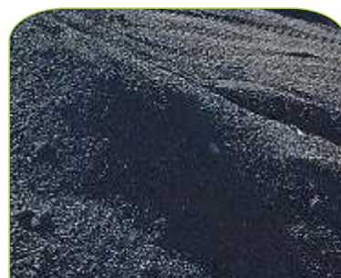
CAPA DE ASFALTO
